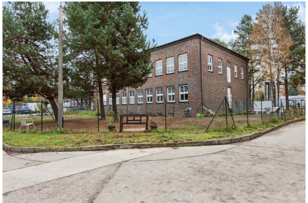
Gebäudeansicht von hinten
