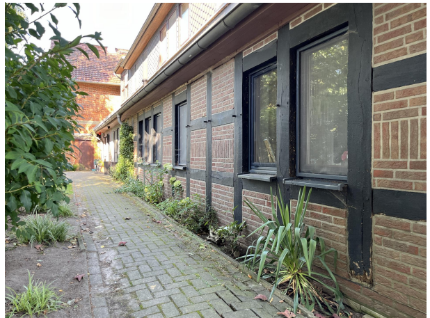
Wohnhaus seitl. Eingangsbereich
